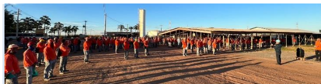
Dia 27, obra no Itapoã Park, com cerca de 550 trabalhadores
