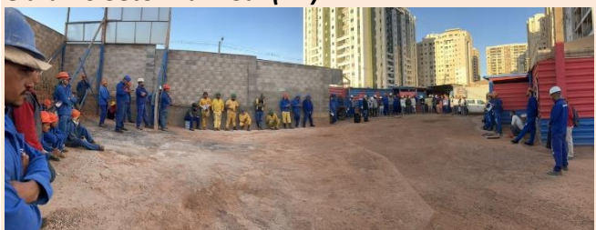
Obra em Samambaia (DF)
